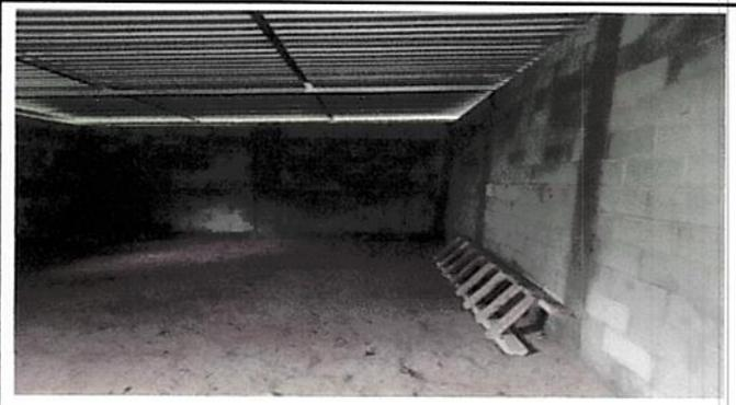
Foto 2: Sustitución de techo de madera por estructura metálica
